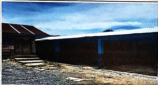
finalización de la instalacón de techo modulo 2.
