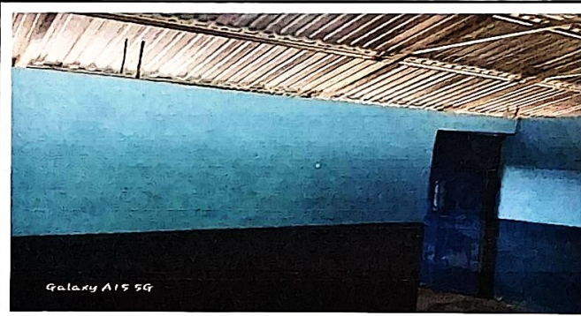
Finalizacion de Intalacón de puertas modulo 2.
