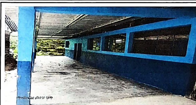
Finalizacion alisado de piso del corredor modulo 2.
