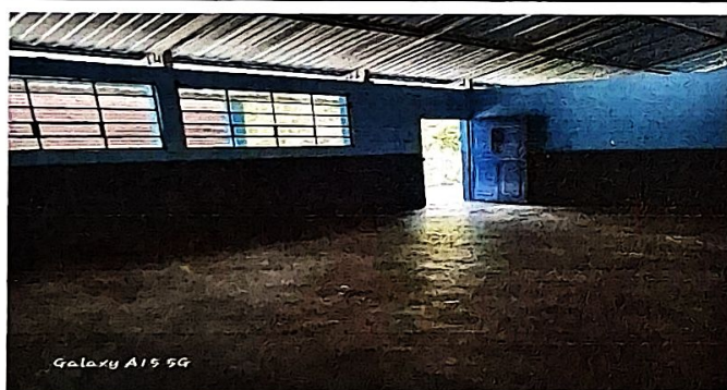
Finalizacón alisado de piso interior modulo 2.
